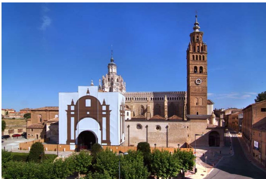
Panorámica actual de la Catedral de Sta. Mª de la Huerta. Tarazona
