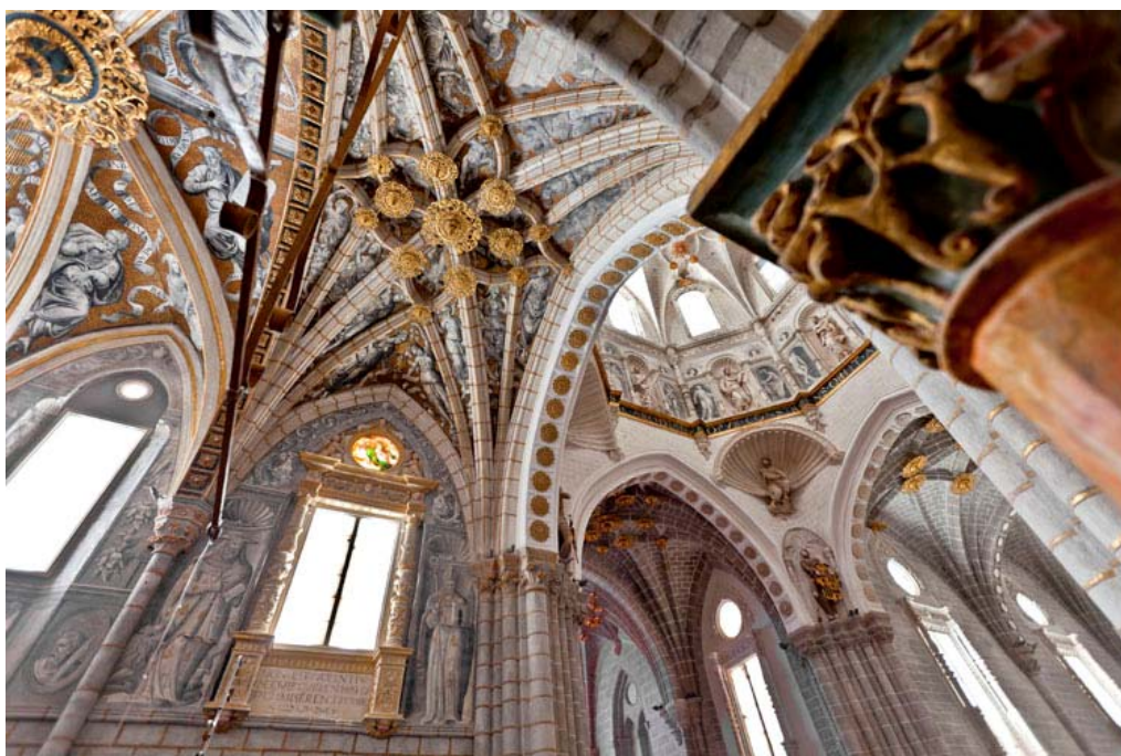
Vista desde el triforio de la capilla mayor y del cimborrio
